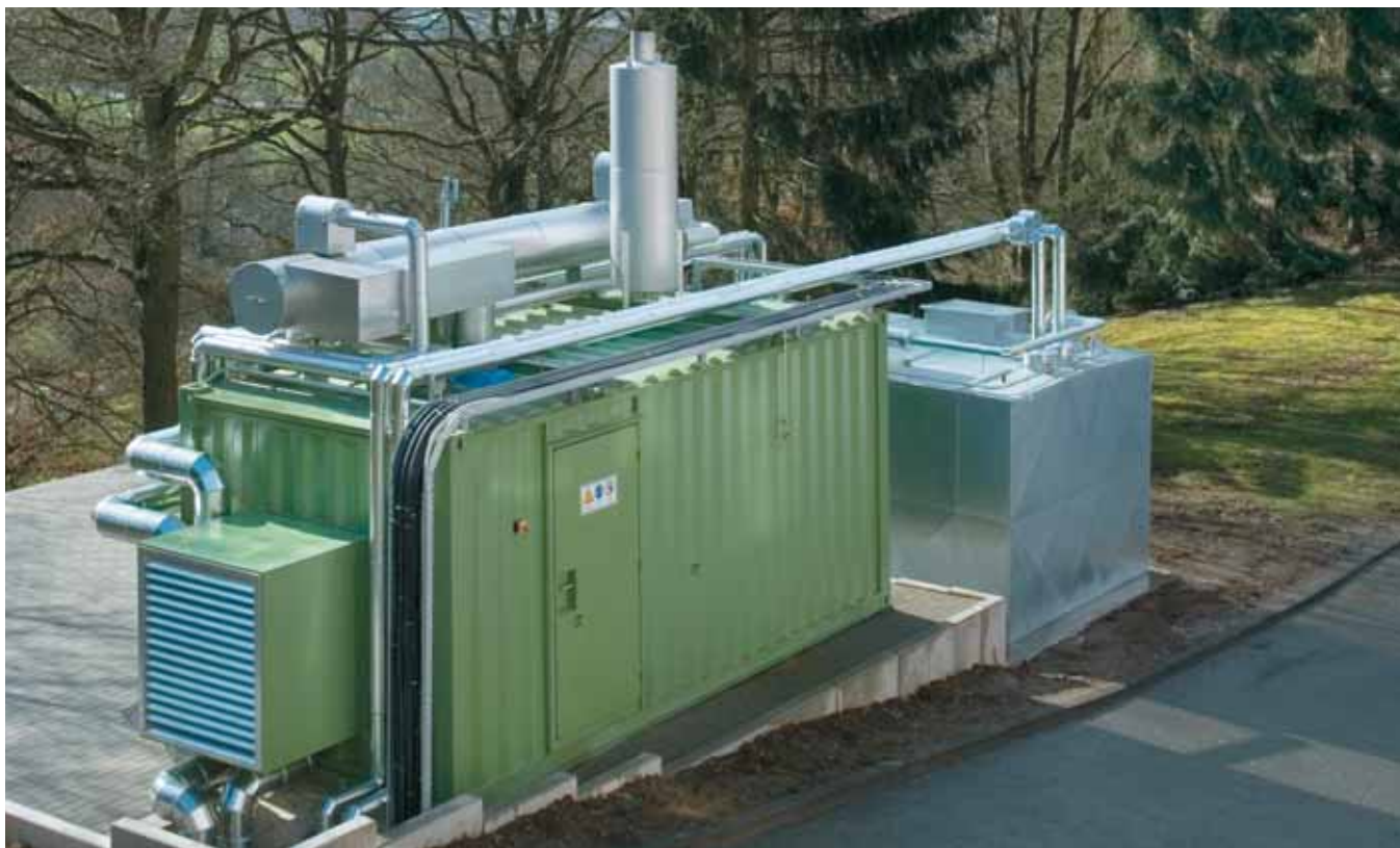
Firma RITTAL u Herbornu, Nemačka. Postrojenje sa rezervoarom za gorivom zapremine 30 m 3 – WE-CG-340-V
