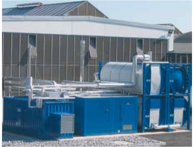
120 kW el. u kontejneru 2 x 24 m 3 tank za lož ulje, 24 m 3 spremnik – STV
